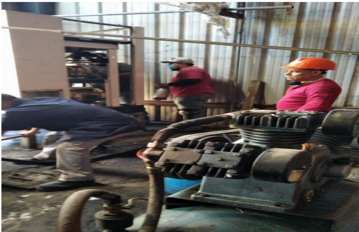
Ilustración 33 Reacomodo de compresor para tintorería
